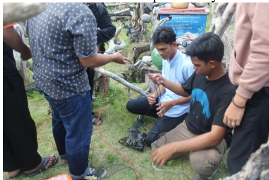
Gambar 9. Proses Pemasangan Solar Panel
