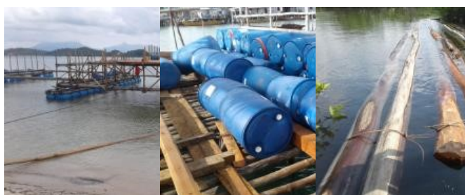
Konstruksi bangunan dari Kelong Drum bekas sebagai pelampung Kayu untuk membangun konstruksi Kelong
