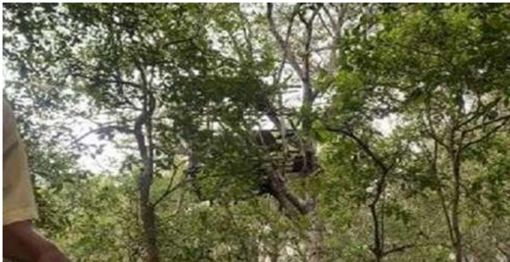
Keterangan: Fasilitas ekowisata (rumah pohon) yang sudah rusak
