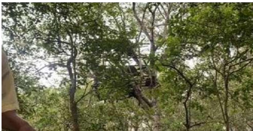
Fasilitas ekowisata (rumah pohon) yang sudah rusak
