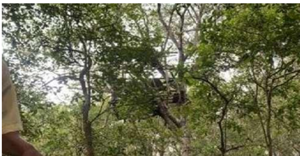
Fasilitas ekowisata (rumah pohon) yang sudah rusak
