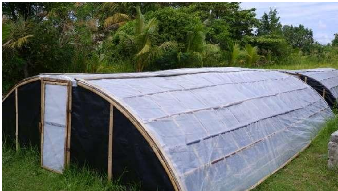
Gambar 4. Tampilan Umum Tunnel Garam Portabel yang Digunakan sebagai Inovasi Produksi Garam Rakyat di Desa Panimbang
