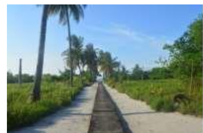
Akses jalan di Pulau Terkulai
